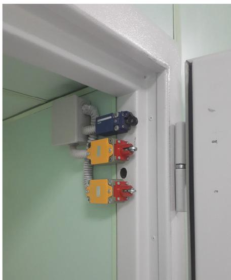
*Рис. 2.5. Концевые выключатели входной двери в процедурный кабинет*
