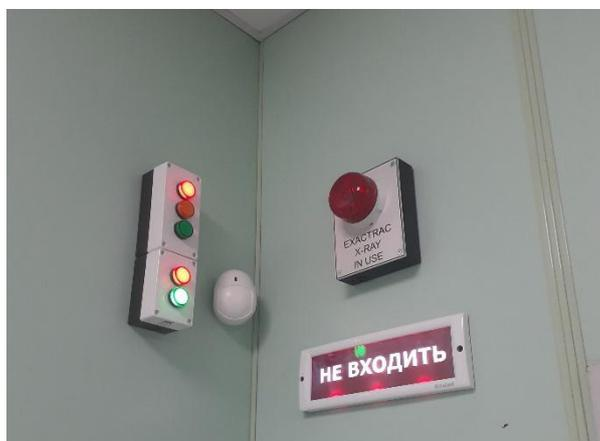
Рис. 2.7. Световое табло индикации включенного пучка
